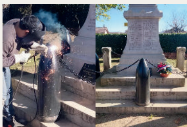
Rénovation du monument aux morts de Marlieux (01)
