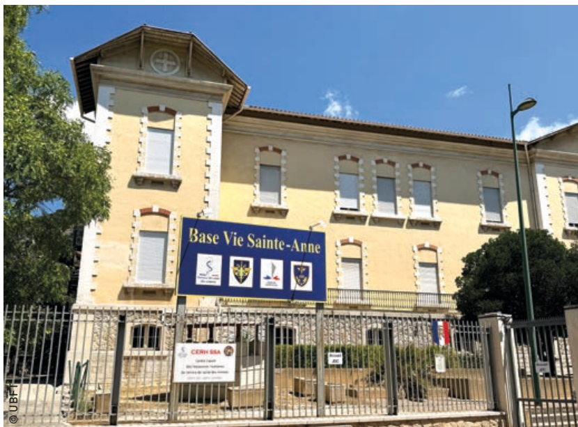
La base de vie où est installé l'hôpital de jour.
