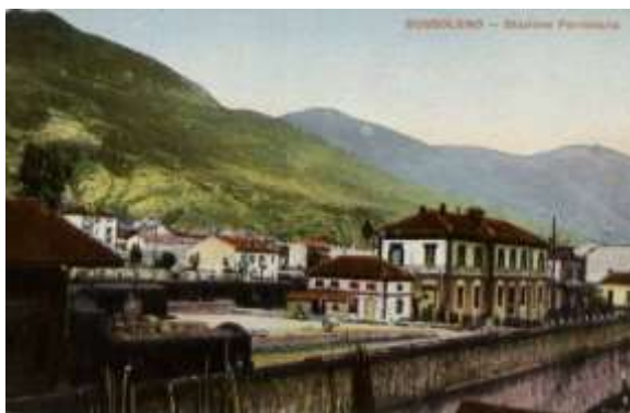
Vue de la ville de Bussoleno depuis la gare.
